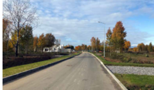
АСФАЛЬТИРОВАННАЯ ПРОЕЗЖАЯ ЧАСТЬ, ВЫВОЗ БЫТОВОГО МУСОРА
